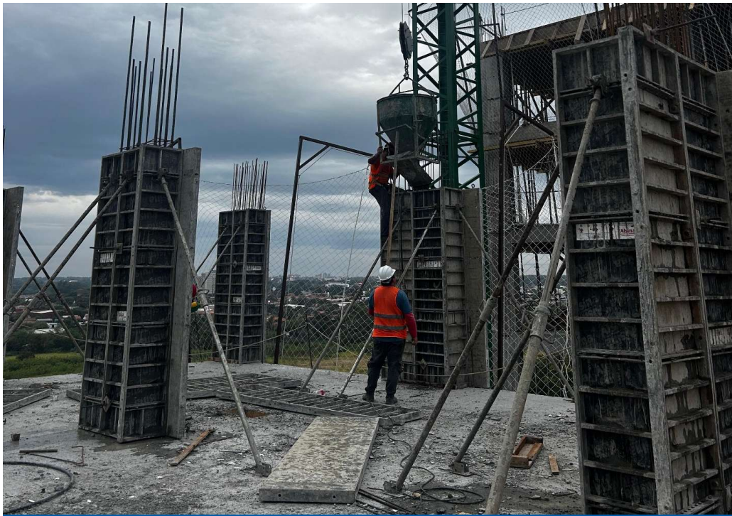
Cargamento de pilares en Torre 20 – Vista lateral de la obra
