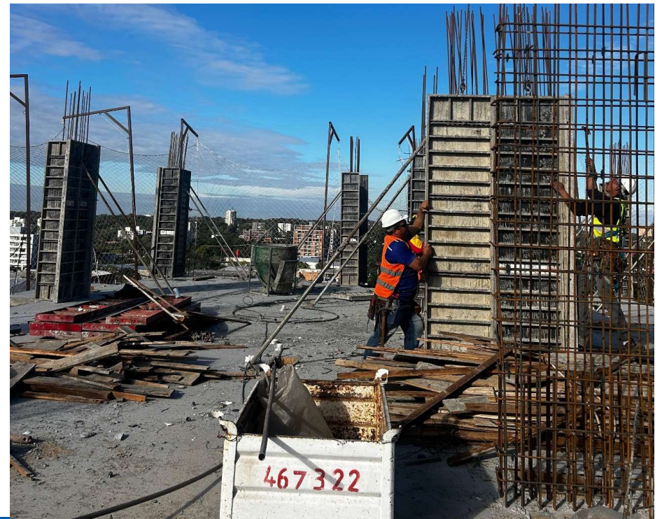
Trabajos de fondeo de losa y encofrado de pilares en Torre 20
